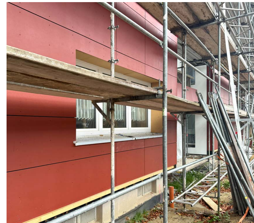
Fassadenplatten in unterschiedlichen Farben wechseln sich mit hellen Putzelementen ab.
